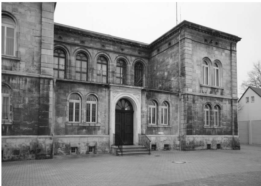
Abb. 50: Naumburg, ehemaliges Schwurgerichtsgebäude: Bendemanns Gemälde Der Tod Abels befindet sich im Treppenhaus hinter den fünf zentralen Rundbogenfenstern
